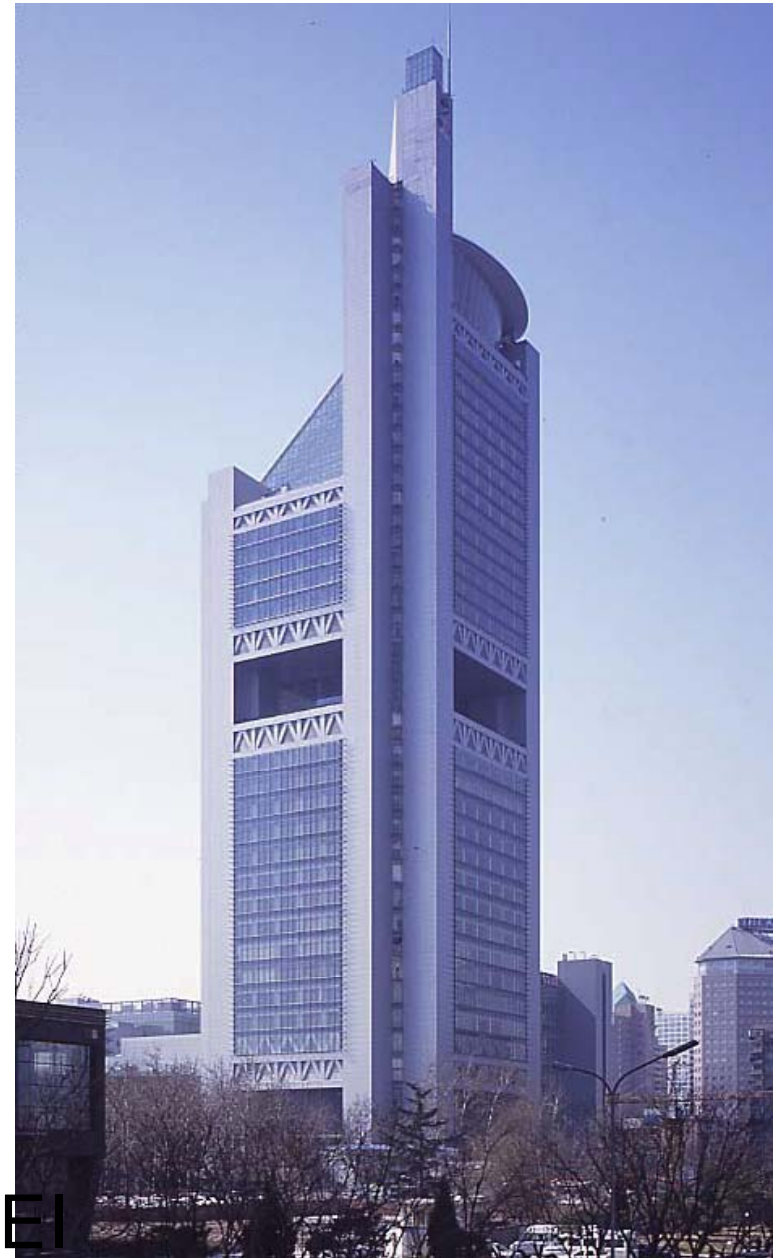
8-3: View of building from northeast. The building's steel superstructure creates a three-dimensional stacking composition. 北東側外観。鉄骨のスーパーストラクチャーによって立体的に積層させた構成としている。 074 | 075
